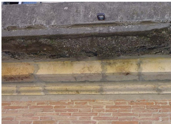
PARTICOLARE DI DETTAGLIO mensola in c.a. e sottostante in pietra
