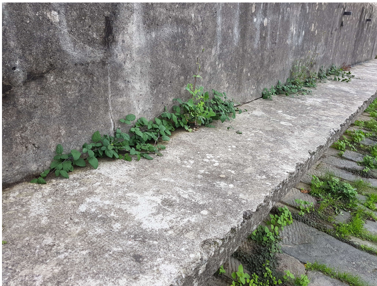
ESEMPIO DI SCONNESSIONE TRA SPALETTA E MENSOLA Notasi la vegetazione che aumenta la sconnessione nel tempo e agevola il dilavamento all'interno dei materiali
