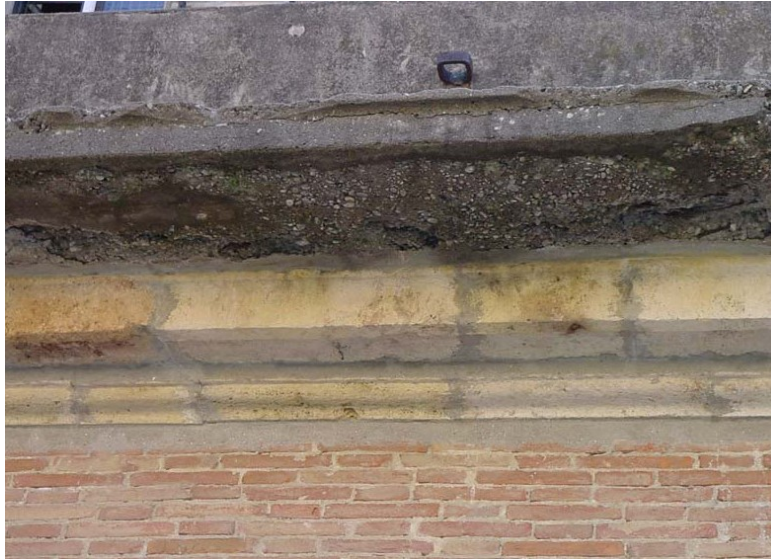
ESEMPIO DI DEGRADO DEL INFRADOSSO mensola in C.A.
