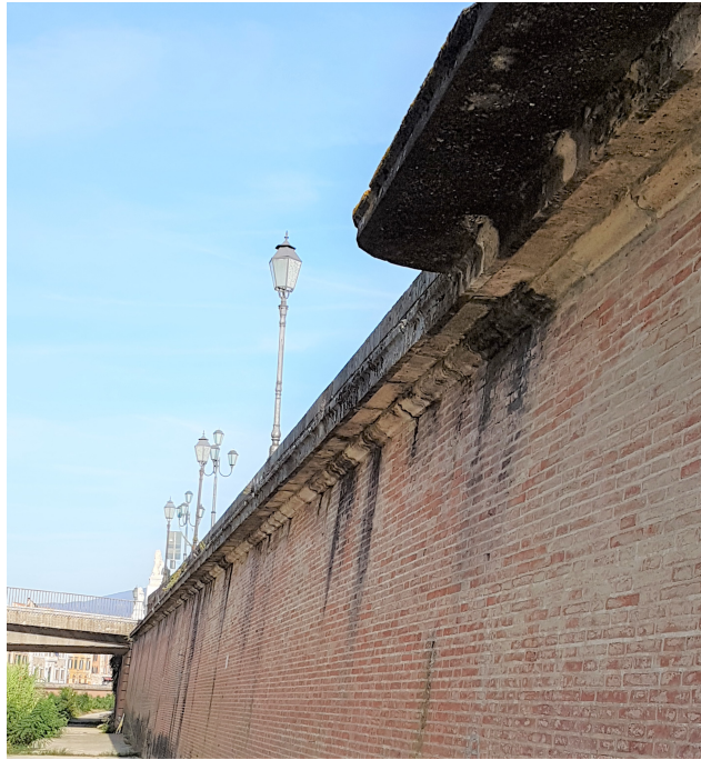
ESEMPIO DI CORNICE/CAMMINAMENTO SOLO INPIETRA In corrispondenza di ponte Solferino (tratto 1)
