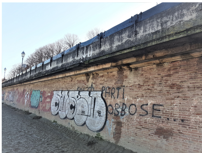
PARTICOLARE D'INSIEME "A CORRERE" mensola in c.a. e sottostante in pietra
